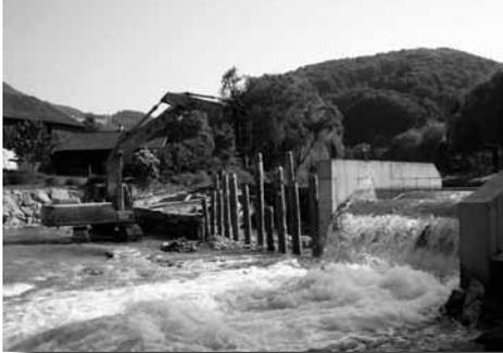
In diesen Tagen wird der Holzkörper der restlichen Wehranlage erneuert. Damit ist ein erster Schritt zur Hochwasserschutz-Verbesserung erfolgt.
